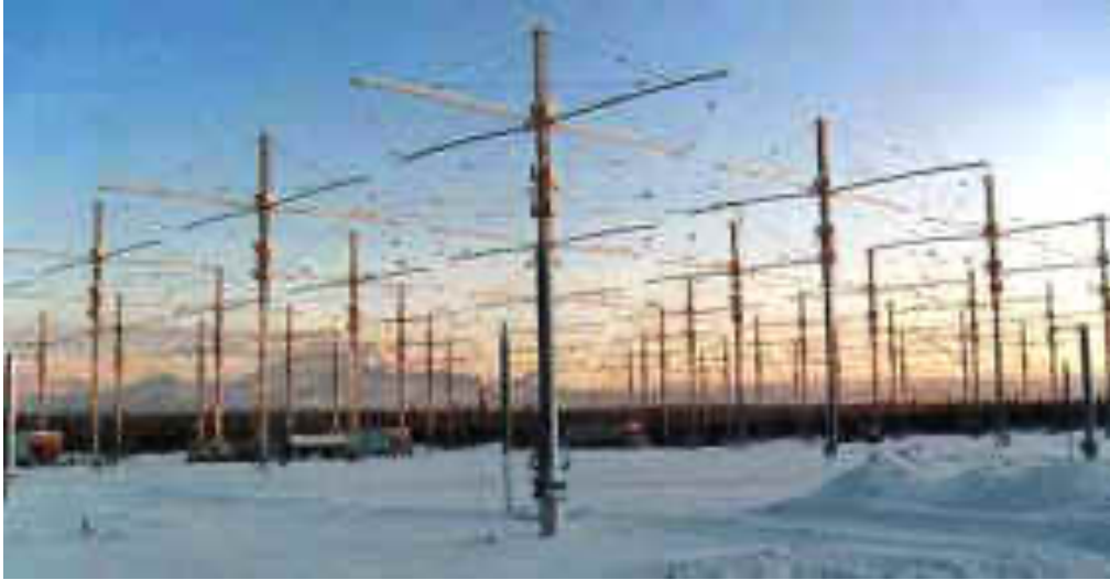
Impianto HAARP a Gakona in Alaska formato da 180 antenne a onde radio.
